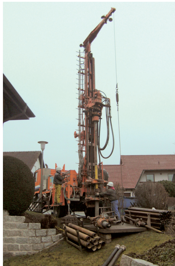
Abb. 1: Bohrung für Erdwärmesonden (Quelle: LfU)
