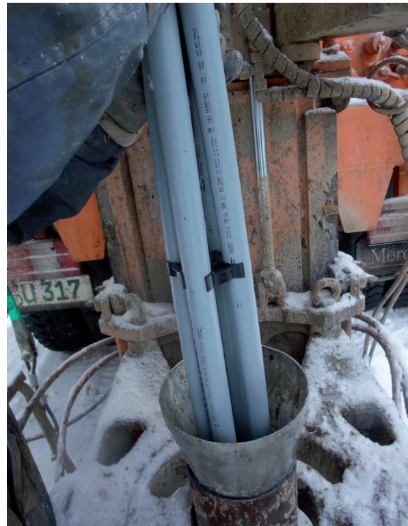
Abb. 8: Einbringen einer Erdwärmesonde mit Innenabstandshalter (Quelle: LfU)
